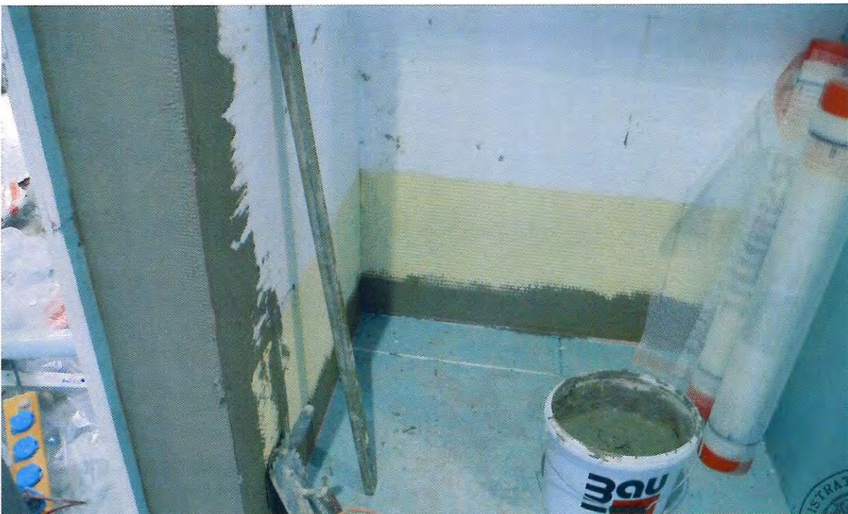
Bild 2: Montage des Prüfkörpers am Prüfstand
