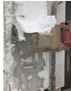
Fotos: Rückbau eines WDVS
