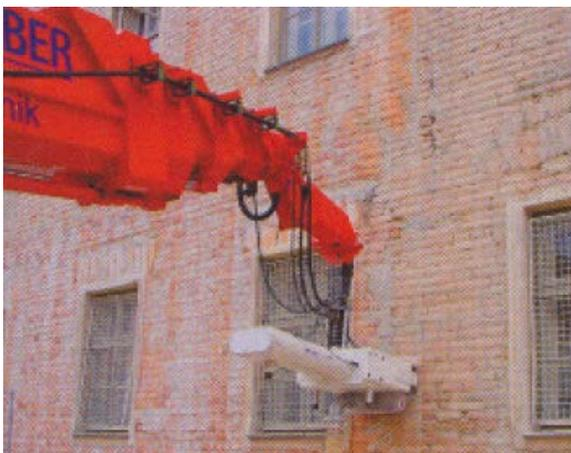
Foto: Fassadenfräse im Einsatz
